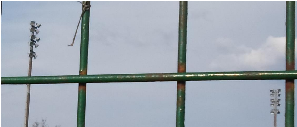
Slika 1.2. Fotografija stupova s postojećim rasvjetnim tijelima
